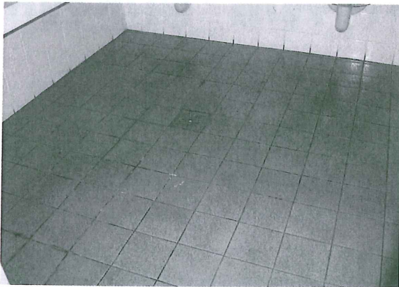
写真1 工場内トイレ(処理前)
