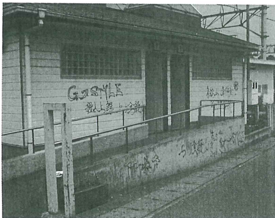
写真4 武蔵嵐山駅公衆トイレ(施工前)
